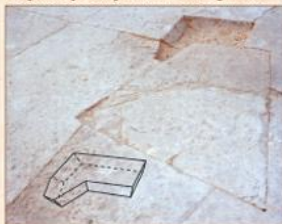
Des pierres anguleuses s'emboîtent parfaitement dans les blocs voisins. La partie manquante avait des angles irréguliers.
